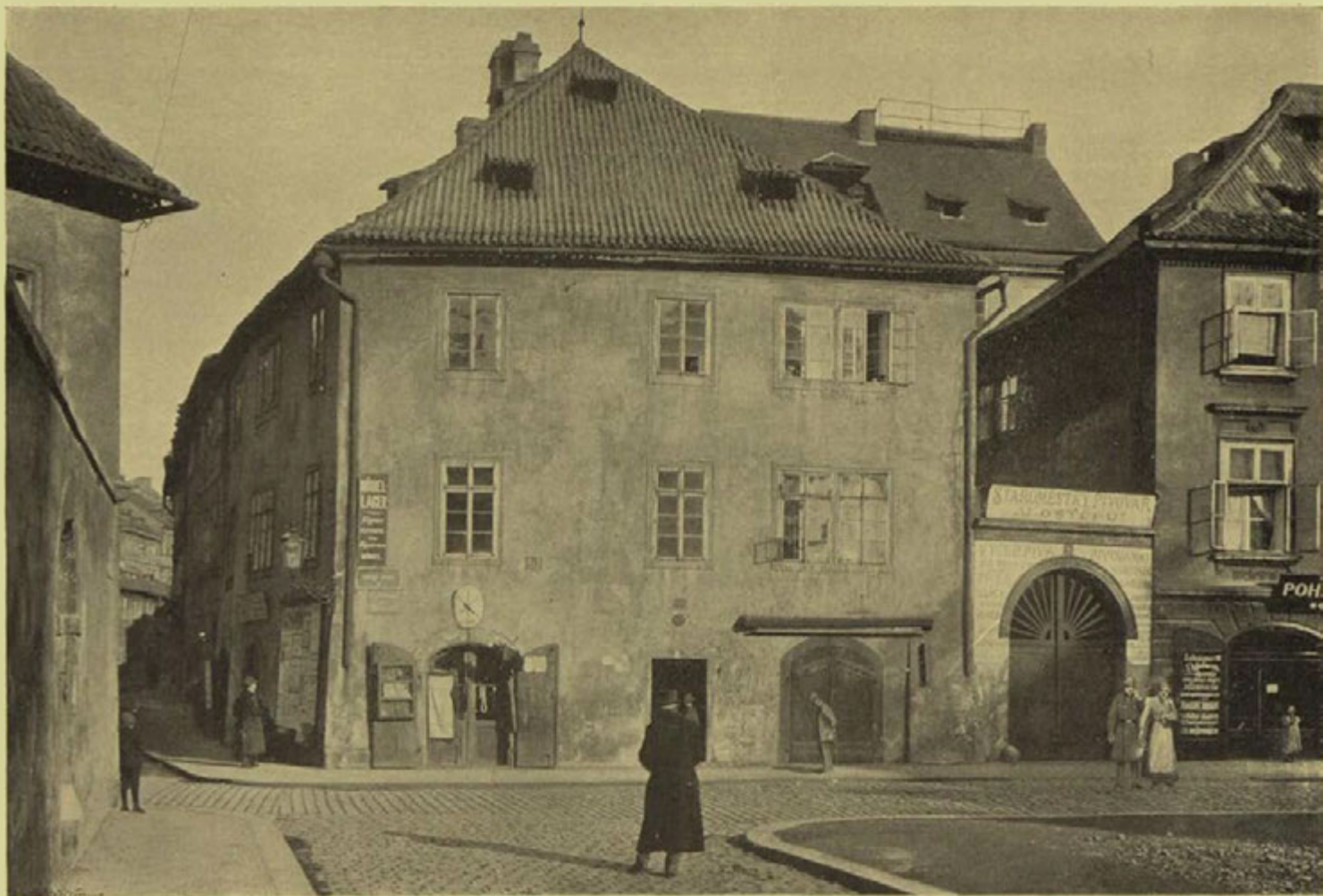
Nároží Dušňá a Věžeňské ulice.
